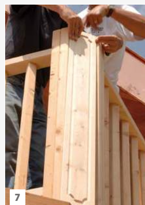
7 positionner la planche d'angle décorative
