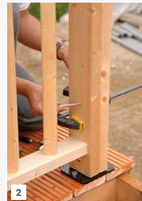
2 présenter le 1er élément, le relier avec le poteau d'extrémité et l'étrier
