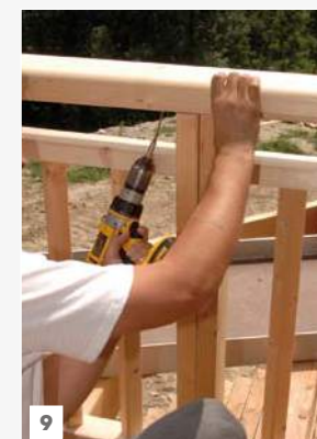
9 coiffer l'ouvrage avec la main courante
