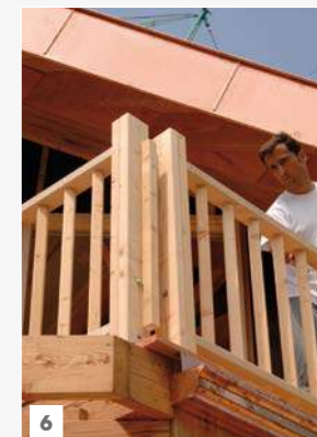
6 présenter l'élément retour et l'assembler
