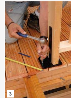
3 placer le 2ème étrier au bout de l'élément et le fixer
