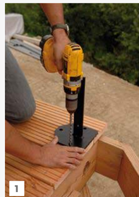
1 placer l'étrier E3 en partant de l'angle
