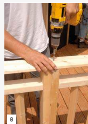
8 mettre en place la lisse sous main courante
